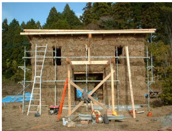
写真3. ベイルを全面に積み上げた様子（第4回）↑
