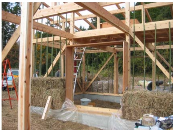
↓写真2. ベイルを壁面に積み上げていく様子（第3回）
