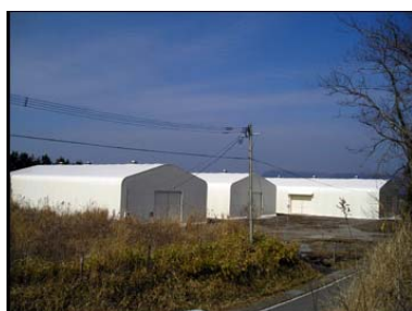
ロールを保管するテント倉庫
