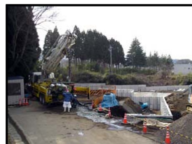
アセリア21の工事状況 (1/19)
